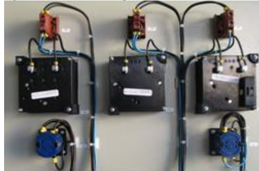
Resim 4.3: Kumanda kablolarına form verilmesi
