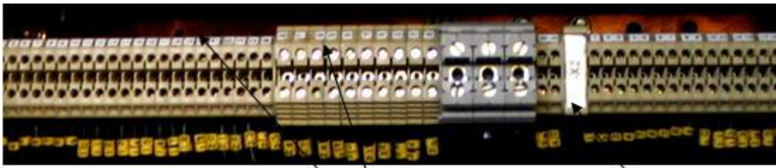
Resim 1.8: Montajı yapılmış klemens etiketleri ve klemens grup etiketleri
